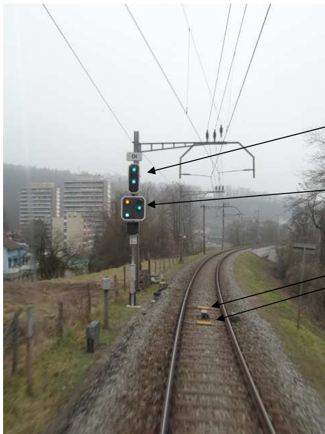
Anhang 6: Abschnittsvorsignal zu Abschnittssignal B161 ausgerüstet mit ZUB Balisen
