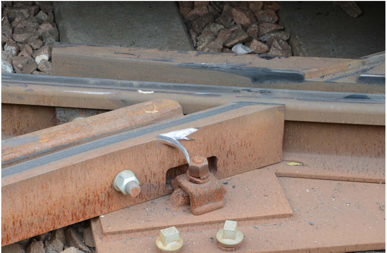
Foto 4: Kreuzungspunkt des Gleises zur Schleife mit dem Gegengleis
